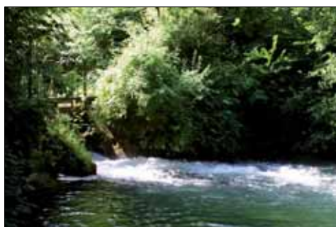
Vannage sur l'Aa
