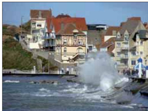
La digue de Wimereux
